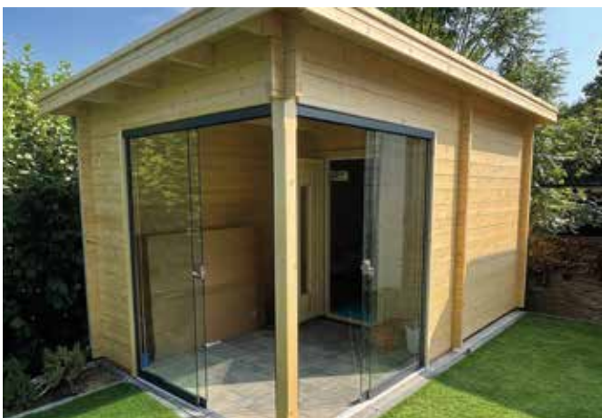
Bauseits farbbehandelt (Gestaltungsbeispiel)
