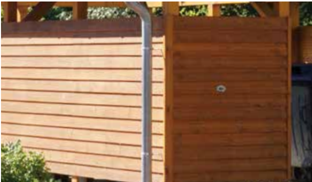
Wänden im Fassadenprofil N+F 28/15 x 141 mm, Lärche naturbelassen – Sondermodell
