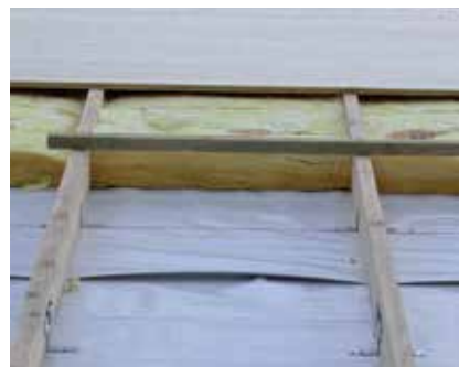
Das doppelschalige Dach für frostige Tage – zur Aufnahme der Dämmung vorbereitet. Aufpreis für Doppelschaliges Dach (für Aufdachdämmung): Dachsparren; zweite Dachschalung; Ortgang- und Traufbretter breiter
