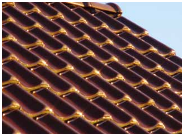
Eine Ziegeleindeckung für das Dach. Joda® bereitet alles vor, inkl. Dachsparren, Latten etc. Aufpreis Dach vorbereitet für Ziegeleindeckung: Dachsparren; Dachlattung; Ortgang- und Traufbretter breiter.
