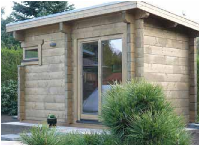
Bauseits farbbehandelt (Gestaltungsbeispiel)
