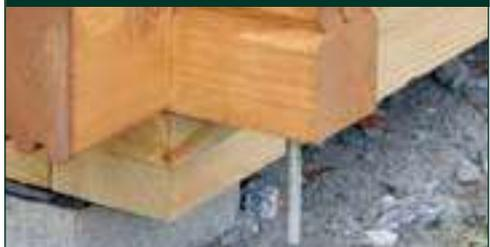
Optimale Auflage der Dachbretter durch abgeschrägte Seitenwandbohle
