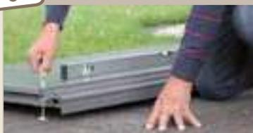
Bodenplatte mittels Stellfüßen in waage bringen.
