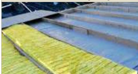
Optimale Auflage der Dachbretter durch abgeschrägte Seitenwandbohle
