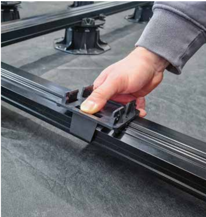
KL-Kreuzverbinder auf die ausgerichtete Konterlattung einklicken
