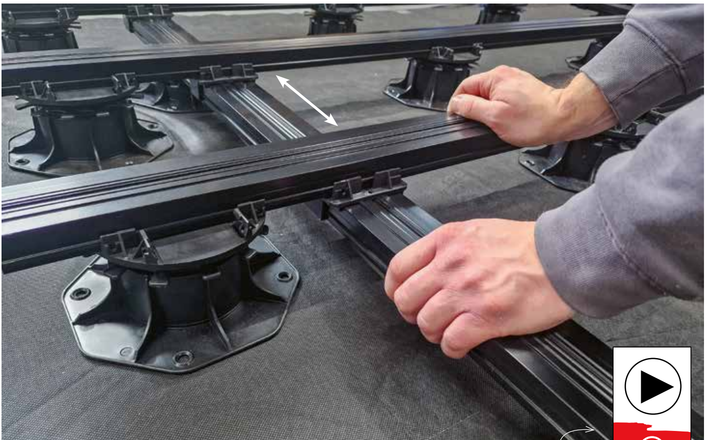
Fixierte Alu-UK einfach an die exakte Position schieben
