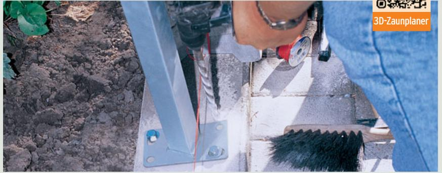
oder mit Pfostenträger aufschrauben.
