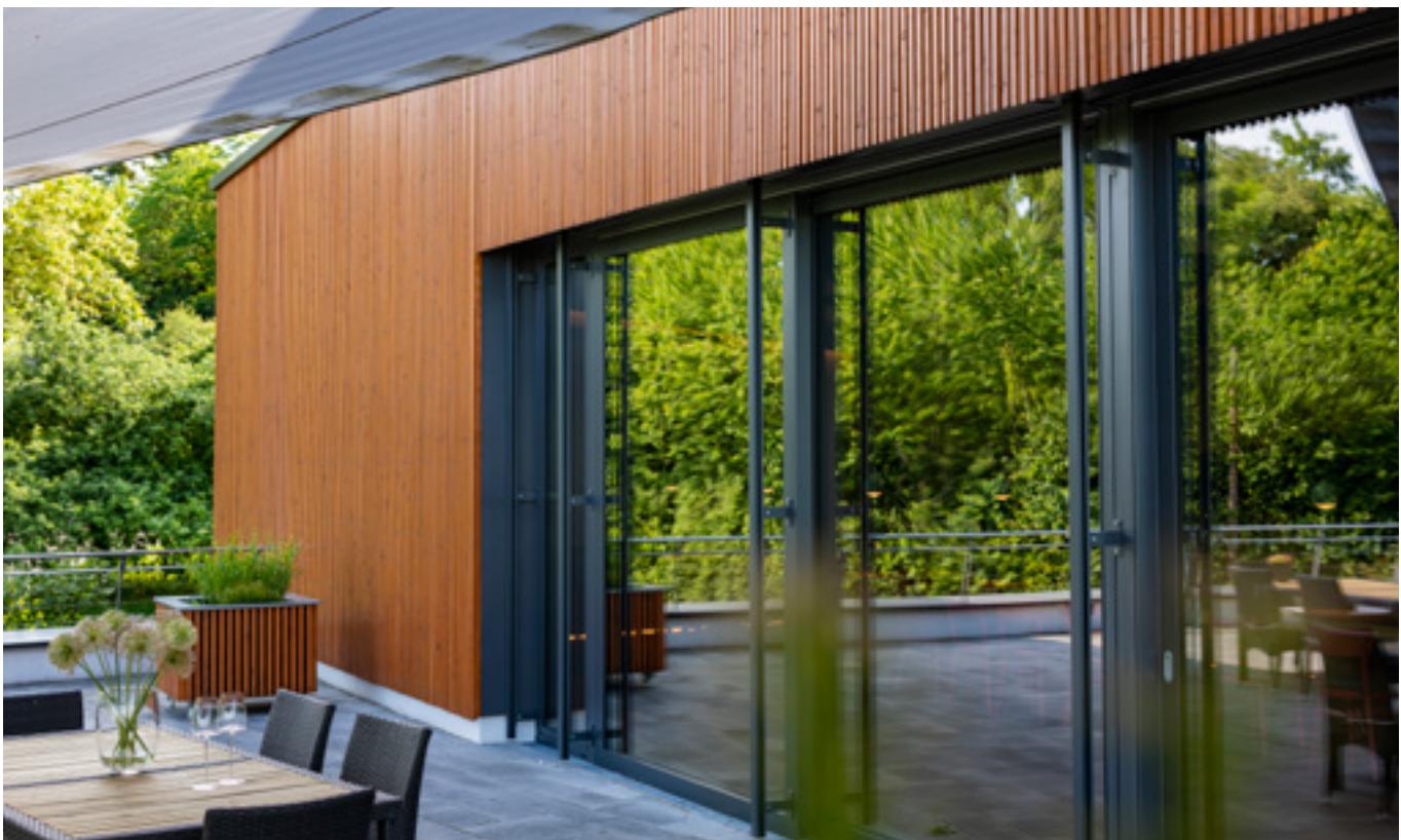
Sonderprofil Rahmen Fichte endbehandelt mit Osmo Holzschutz Öl-Lasur 708 Teak
