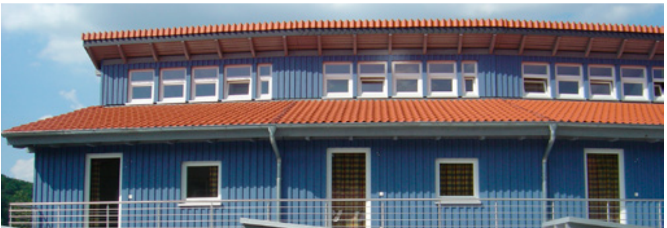
Boden-Deckelschalung, Fichte, endbehandelt mit Osmo Landhausfarbe RAL 5012 Lichtblau
