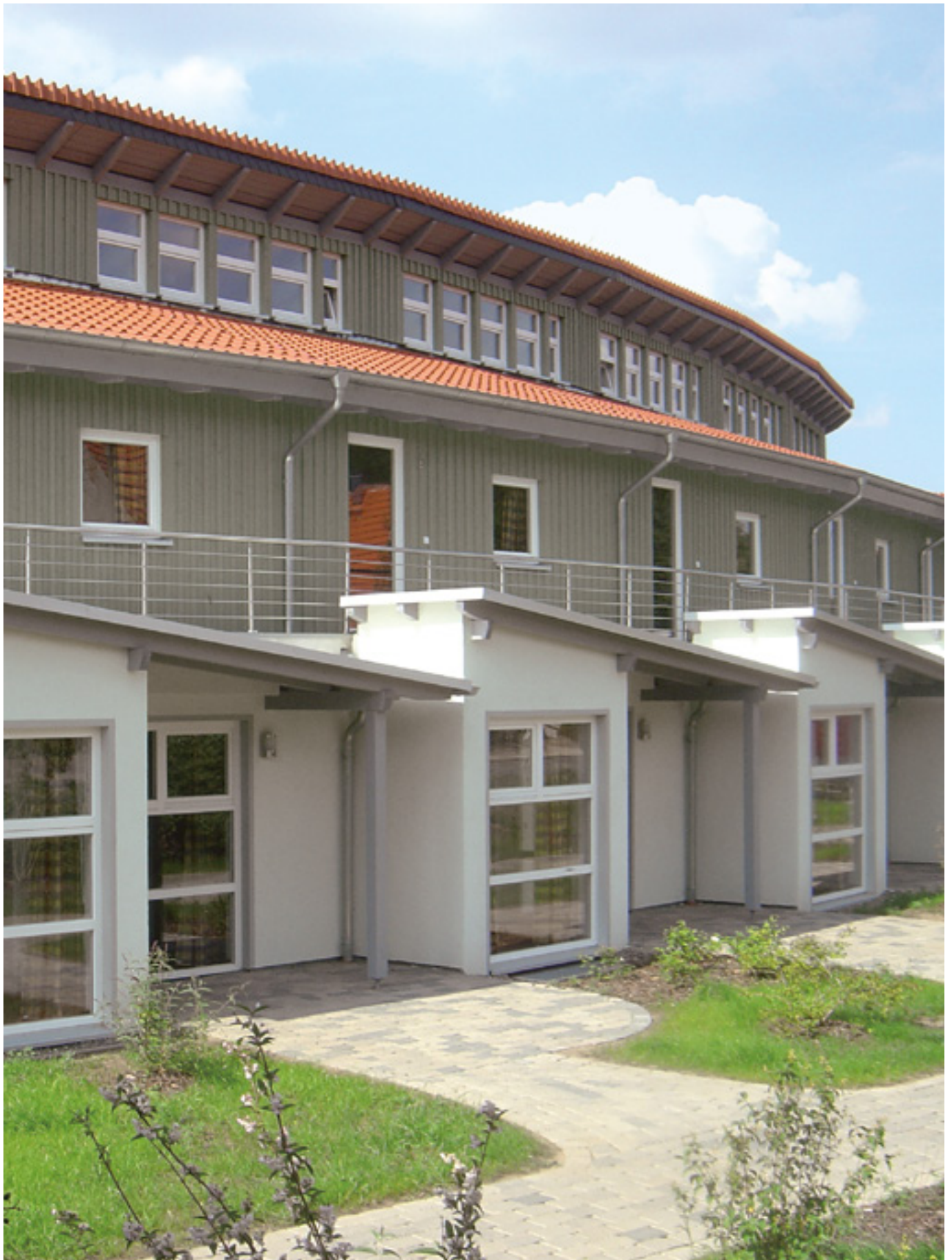
Boden-Deckelschalung, Fichte, endbehandelt mit Osmo Landhausfarbe RAL 7002 Olivgrau
