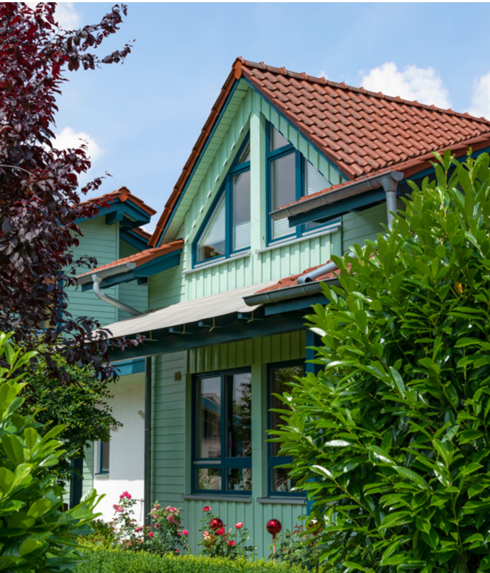
Boden-Deckelschalung Fichte in Kombination mit Cono Fichte, beides endbehandelt mit Osmo Landhausfarbe RAL 6027 Lichtgrün
