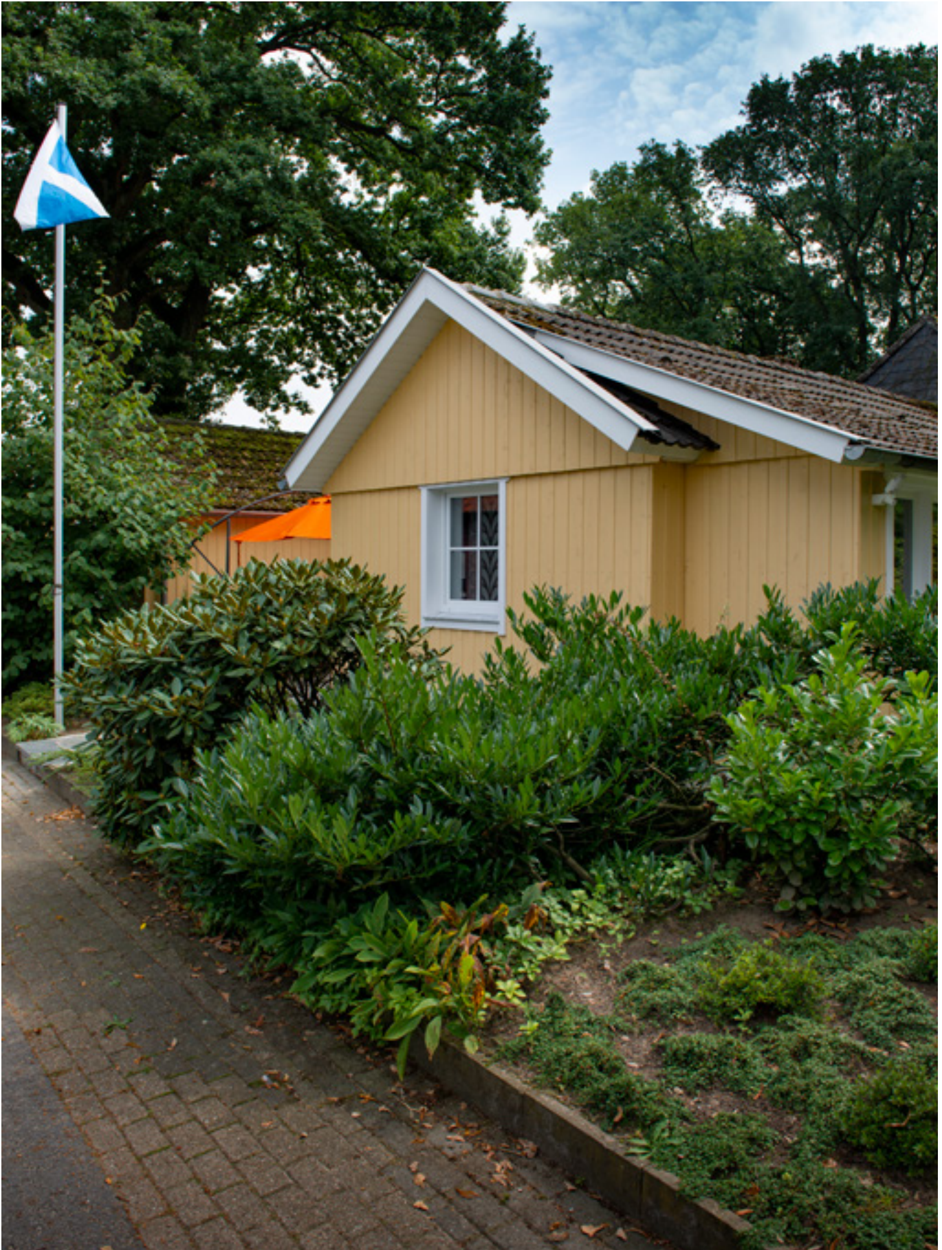
Boden-Deckelschalung, Fichte, endbehandelt mit Osmo Landhausfarbe 2204 Elfenbein
