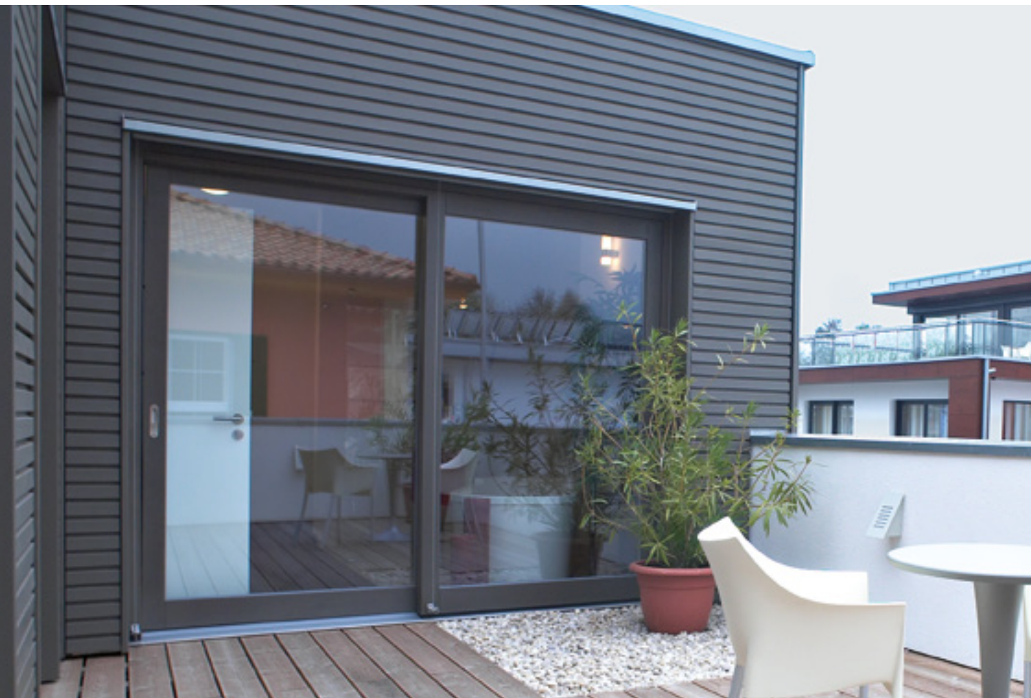
Rautenprofil, Fichte, Sichtseite gesägt, endbehandelt mit Osmo Holzschutz Öl-Lasur Effekt 1143 Onxysilber
