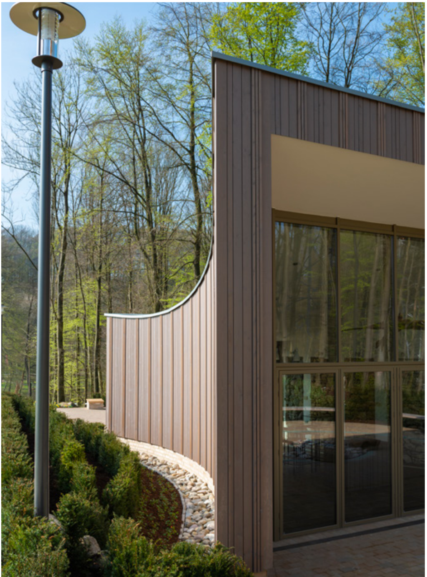
Verto, sib. Lärche riffelgesägt, endbehandelt mit Osmo Holzschutz Öl-Lasur Effekt 1140 Achatsilber
