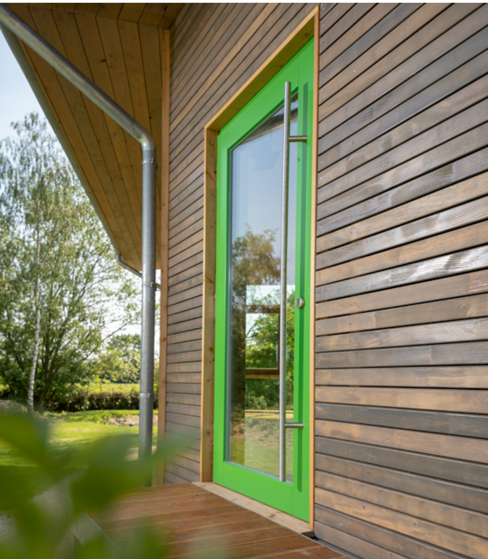
"Patchwork-Fassade" auf Kundenwunsch bestehend aus: Rautenleisten, Weiß-Tanne, vorbehandelt und teilweise endbehandelt mit Osmo Holzschutz Öl-Lasur 905 Patina
