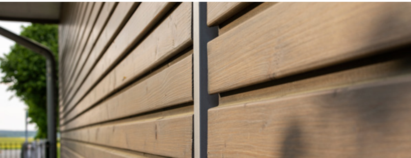
Rautenleiste mit Nut und Feder, Fichte, endbehandelt mit Osmo Holzschutz Öl-Lasur Sonderton Cremegrau
