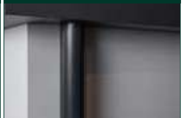
Integrierte Dachrinne / 1 Fallrohr
