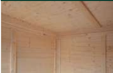
Fertig isolierte Dachelemente, 75 mm
