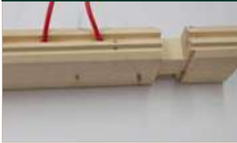
inkl. Bohrungen für Elektroleitung des Saunaofens
