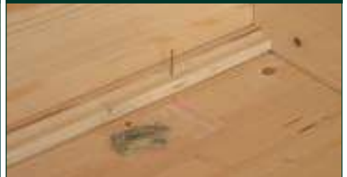
Untere Dachabschlussleiste zur einfachen Dachrinnenmontage
