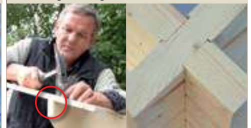
Optimale Auflage der Dachbretter durch abgeschrägte Seitenwandbohle
