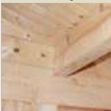
Dachpfetten 70x180 mm; Dachbelastbarkeit über 180 kg/m²
