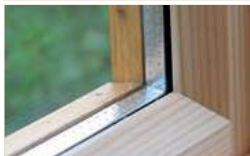
Isolierverglasung zum Schutz vor Kälte ab 44 mm Bohlenstärke
