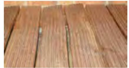
**Wechsel-Dreh-Wuchs:** Harthölzer neigen teilweise stärker zum sogenannten Wechsel-Dreh-Wuchs. Es ist daher besonders wichtig, dass die empfohlenen Abstände zwischen den Auflagerepunkten auf der Unterkonstruktion eingehalten werden, damit das Holz „gehalten“ werden kann.
