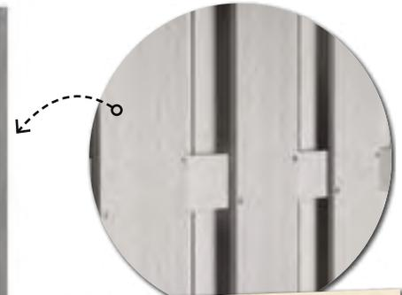
Querriegel aus pulverbeschichtetem Aluminium
